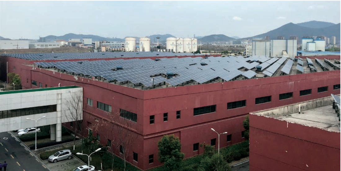
熊貓裝備產業園屋頂光伏電站
